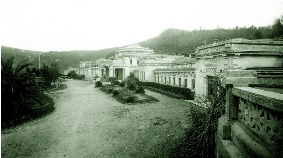
L'edificio termale alla sua origine
