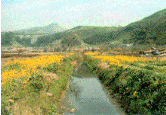
Terme di Agnano Canale di bonifica nella piana di Agnano
